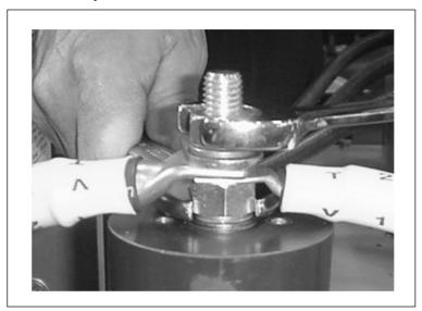
FIGURA 20. SUJECIÓN CORRECTA DE CABLES (VARIOS CABLES)
