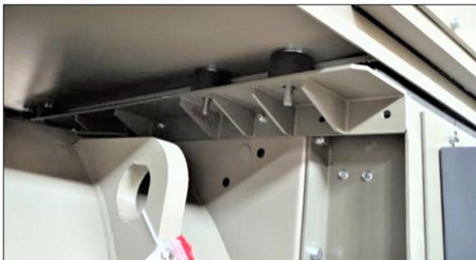
图 7. 将水冷却器降低到正确位置
