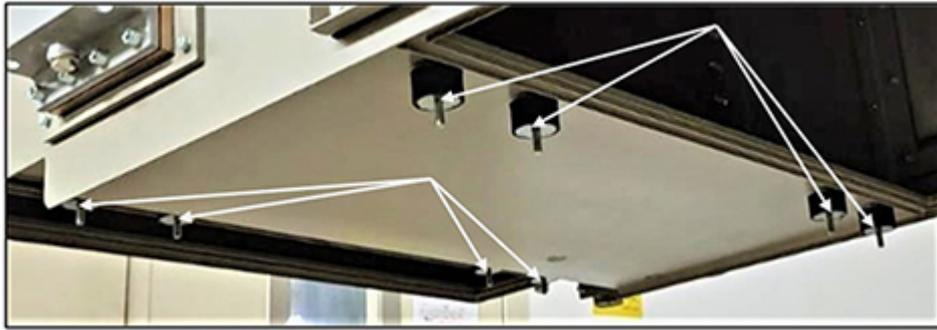
**ABBILDUNG 4. 8 SCHWINGUNGSDÄMPFENDE LAGER MIT 6-MM-UNTERLEGSCHIEBEN, MONTIERT AN DER UNTERSEITE DES WASSERKÜHLERS.**
