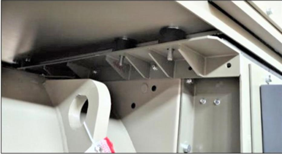
**FIGURA 7. ENFRIADOR DE AGUA BAJADO HASTA SU POSICIÓN**
