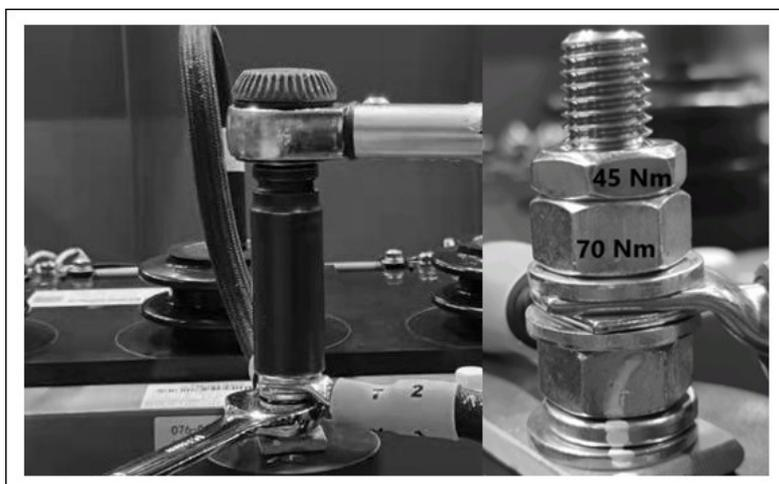
FIGURA 25. FIXAÇÃO CORRETA DOS CABOS (MÚLTIPLOS CABOS)
