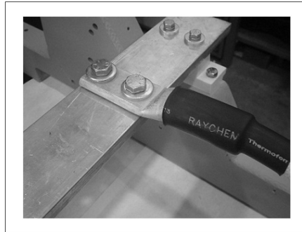
الشكل 25. التثبيت الصحيح للكابلات
