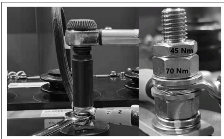
FIGURA 19. SUJECIÓN CORRECTA DE CABLES (VARIOS CABLES)
