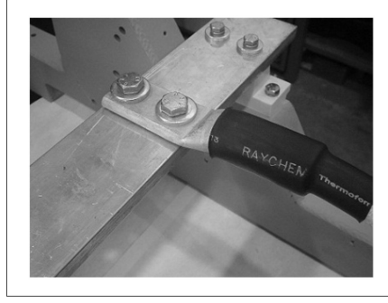
الشكل 27. التثبيت الصحيح للكابلات
