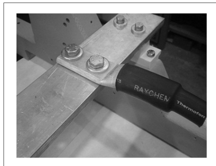
图 27. 正确夹紧线缆
