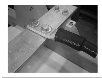
図 27. 適切なケーブル クランピング
