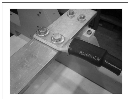
FIGURA 27. FIXAÇÃO CORRETA DO CABO COM BRAÇADEIRA
