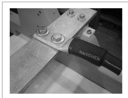
FIGUR 27. KORREKT KABELFASTSÄTTNING
