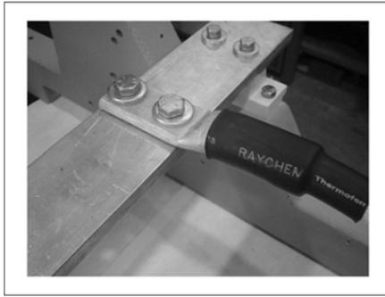
FIGURA 21. SUJECIÓN CORRECTA DE CABLES (CABLE ÚNICO DE CARGA)
