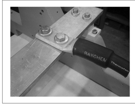
FIGURE 25. BRIDE DE CÂBLE CORRECTE
