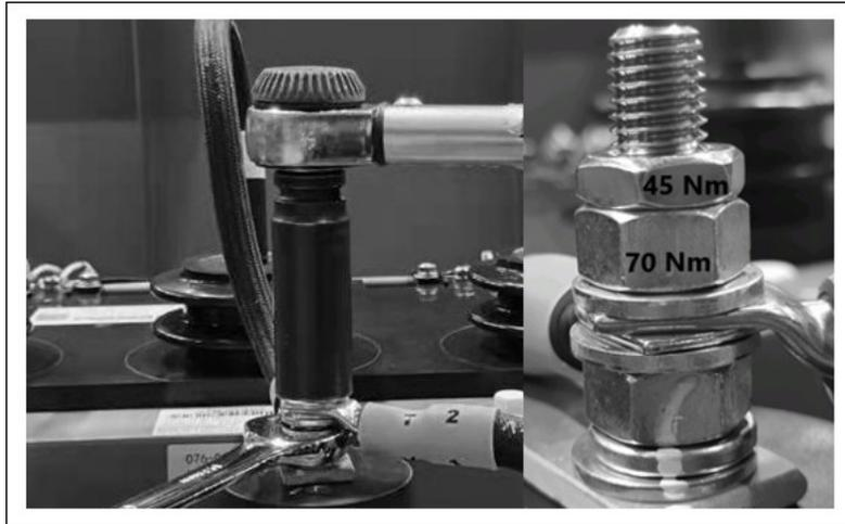
FIGURA 21. SUJECIÓN CORRECTA DE CABLES (VARIOS CABLES)
