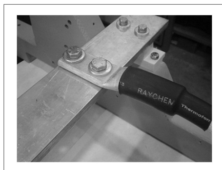
图 25. 夹紧正确的线缆
