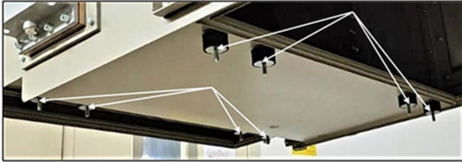
الشكل 8. 9 x حوامل مضادة للاهتزاز بما في ذلك الوردات مقياس 6 مم مثبتة على الجانب السفلي من مبرد المياه.
