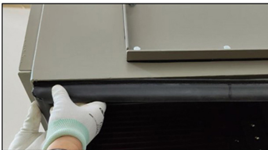
图 11. 安装后的垫片
