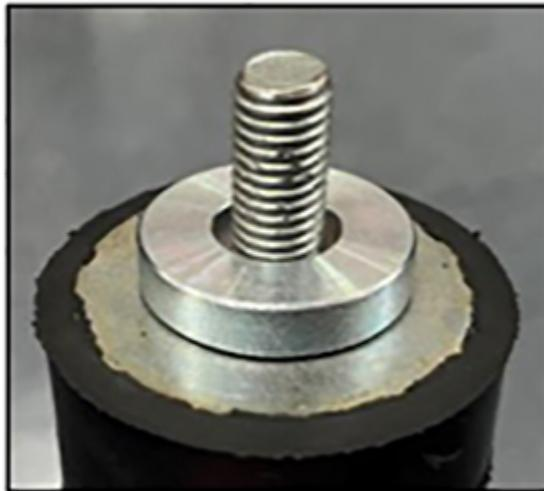
図 8. 防振マウントの上部に取り付けるフラット ワッシャー。
