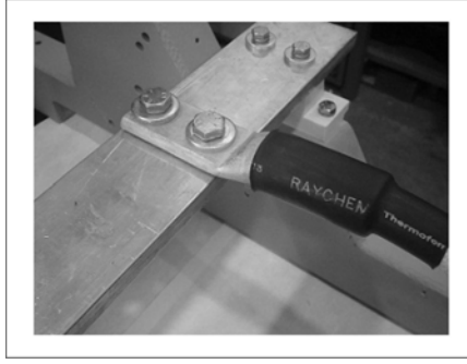
رسم توضيحي 21. تثبيت محكم للكابيل (كابل تحميل أحادي)
