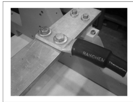
図 21. 正しいケーブル クランピング (単一のロード ケーブル)
