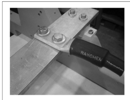
FIGURA 21. BRAÇADEIRA DE CABO CORRETA (CABO DE CARGA ÚNICO)
