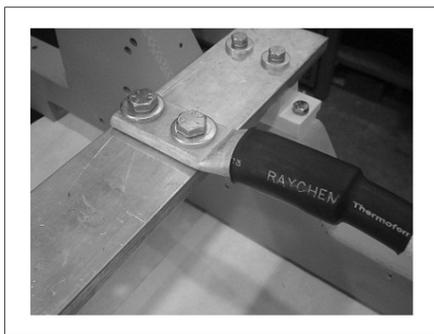
FIGURA 25. SUJECCIÓN CORRECTA DE CABLES
