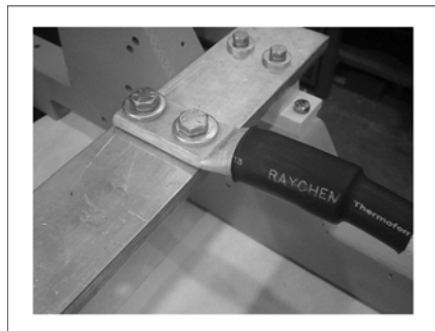
图 21. 夹紧正确的线缆（单负载线缆）
