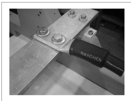
FIGURA 25. CORRETTO FISSAGGIO DEI CAVI
