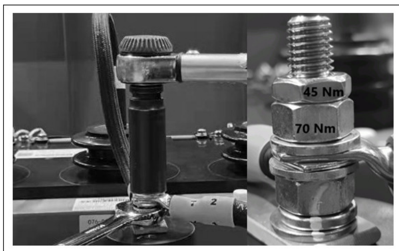
FIGURA 19. SUJECIÓN CORRECTA DE CABLES (VARIOS CABLES)
