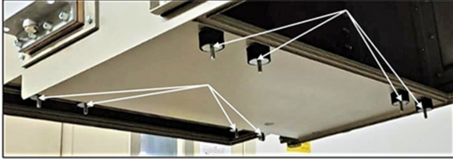
الشكل 8. 7 x حوامل مضادة للاهتزاز بما في ذلك فلكات مقاس 6 مم مثبتة في الجانب السفلي من مبرد الماء.
