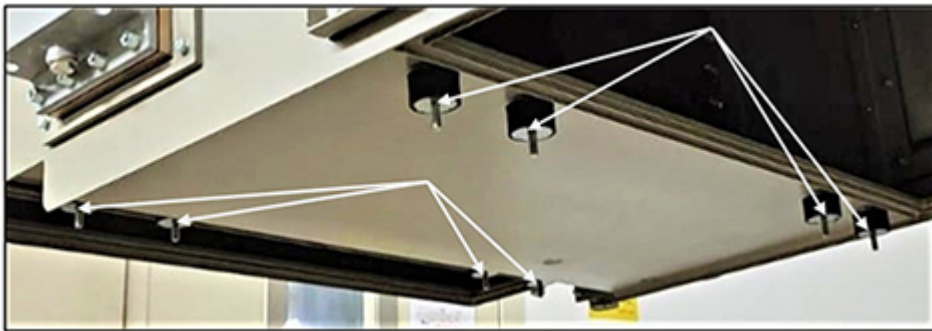
图 7. 将 8 个防振支架连同 6 毫米垫圈安装到水冷却器的下面。
