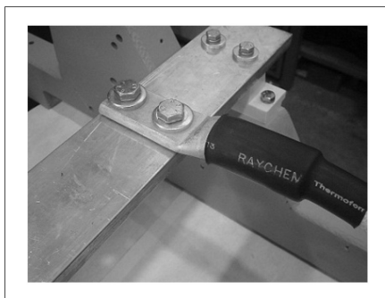
RYSUNEK 25. POPRAWNE ZACISKANIE PRZEWODÓW
