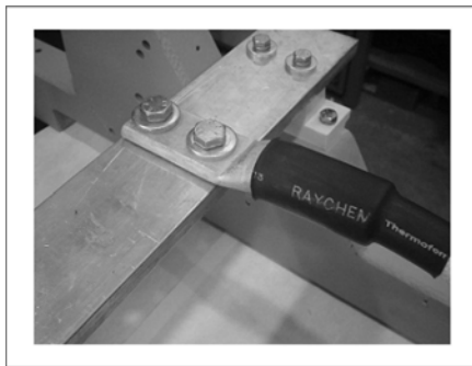
FIGUR 21. KORREKT KABELFASTSÄTTNING (EN BELASTNINGSKABEL)
