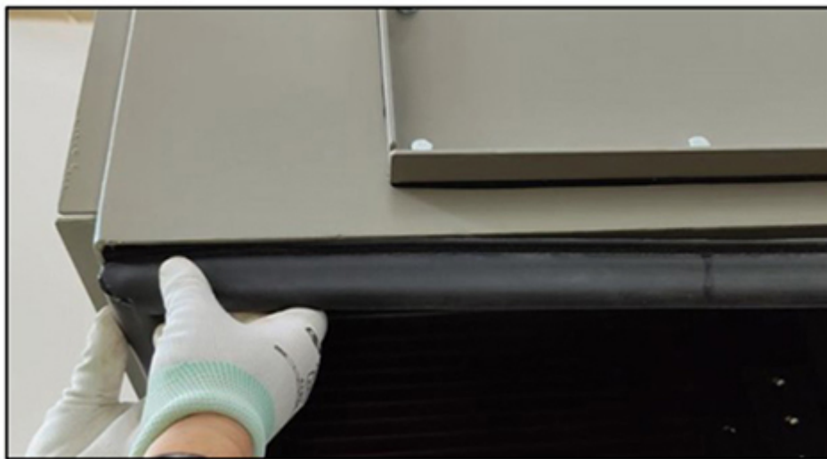
ABBILDUNG 9. MONTIERTE DICHTUNG
